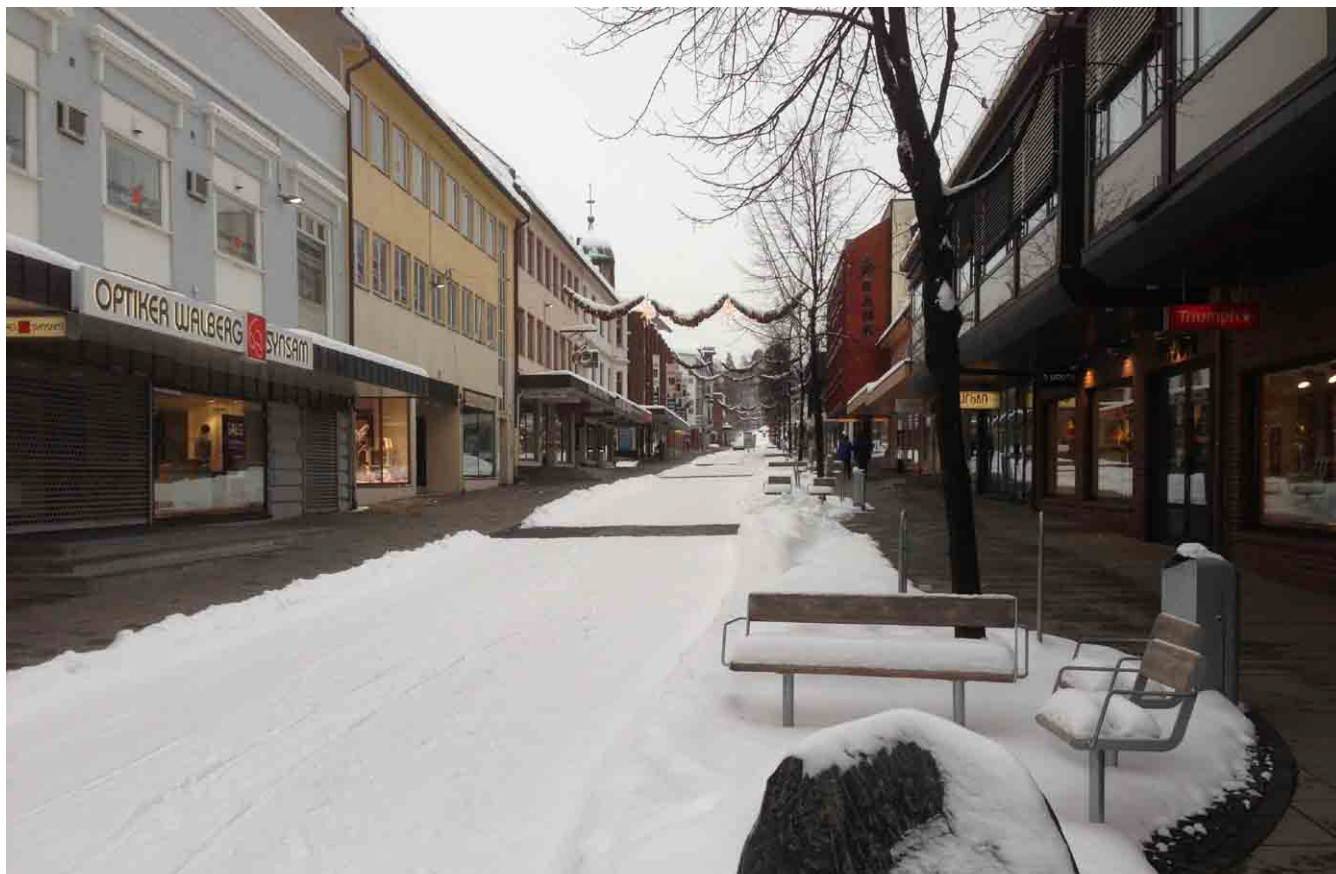
Snøsmelteanlegget i Storgata i Gjøvik ble startet opp i begynnelsen av desember 2011 og har til sammen en smelteflate på 4 895 m 2 . Foto: Frode Granås
